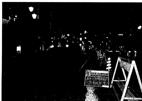
写真-1 都市内夜間工事状況
