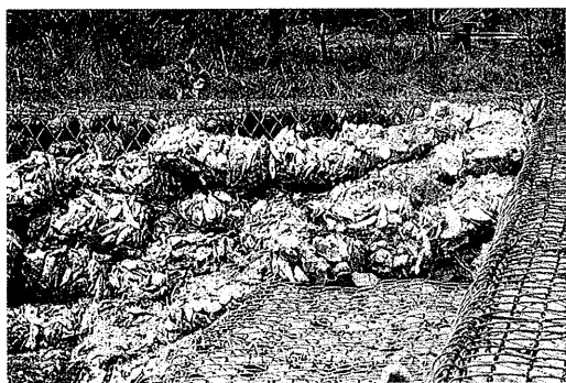
写真-5 蠣殻の傾斜路
