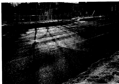
写真-1 排水性舗装区間(左側)と通常舗装区間(右側)(1997年12月25日7時)
