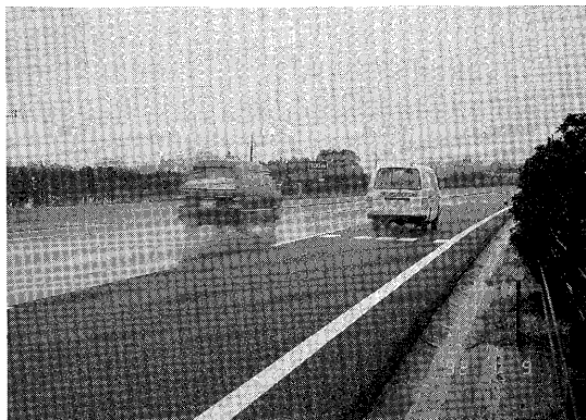
写真-10 排水性舗装 (追越車線)
