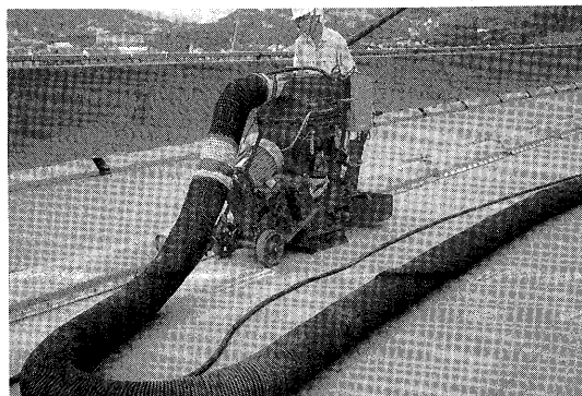
写真-3 遠心バキュームプラスト機を用いた研掃工
