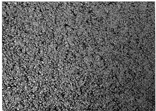
写真-1 密粒ギャップ舗装仕上り面 (四国縦貫自動車道)
