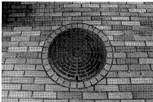
写真—4 マンホール蓋
