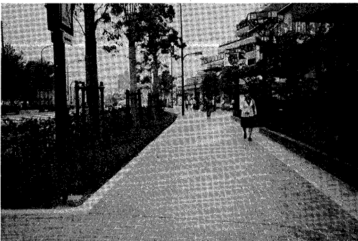
写真—12 歩道の路面状況
